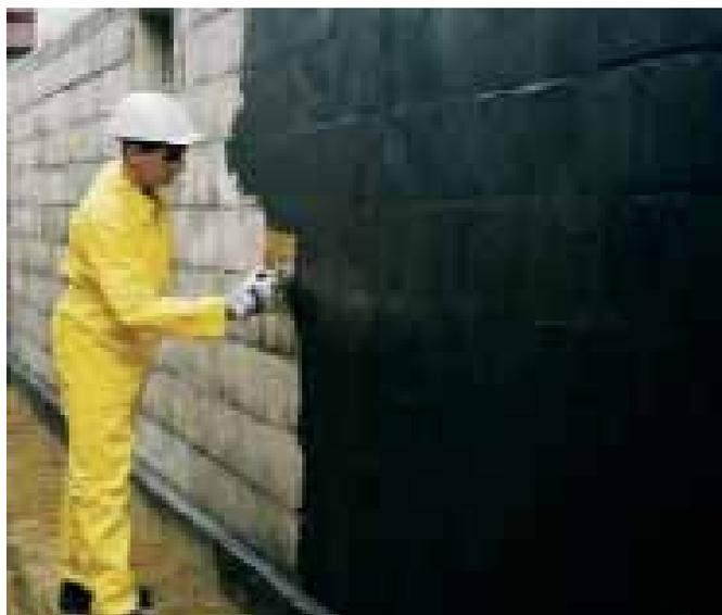
Impermeabilização de parede utilizando solução líquida de asfalto.
