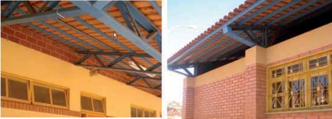
Ventilação sobre forro utilizando tijolos furados e abertura livre.
