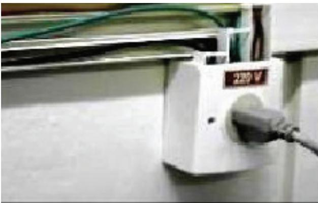
*Exemplo de canaleta externa para passagem da fiação elétrica.*
