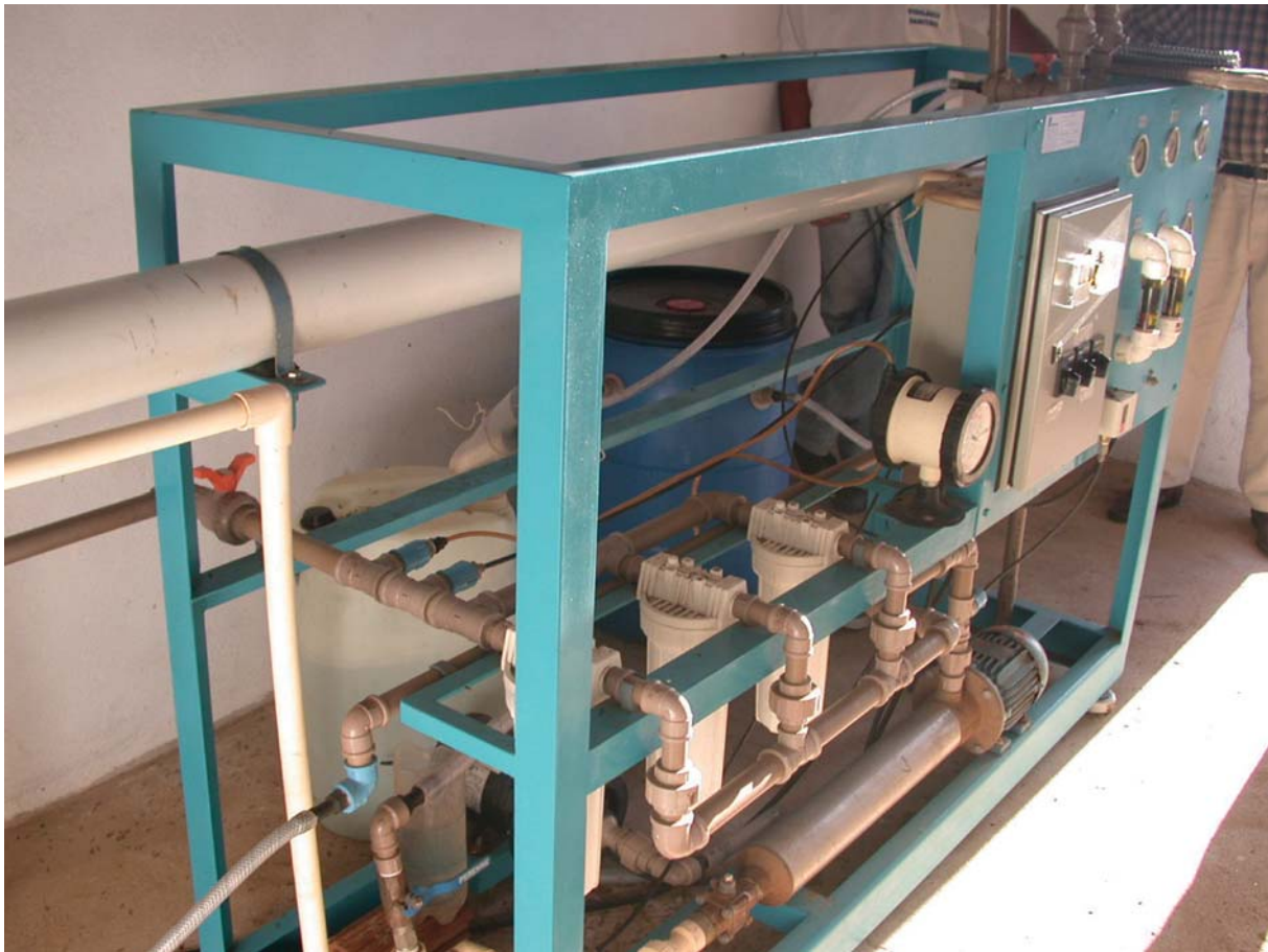
Dessalinizador por osmose reversa
