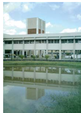
Lagos resultantes do aterro em terreiro de mangue.
