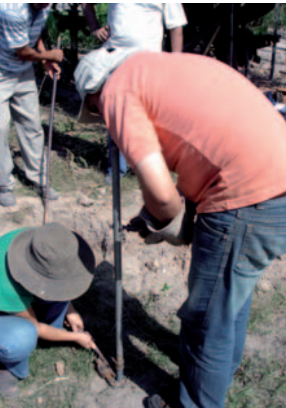
Alunos do Cefet/MT realizando estudos do solo durante a construção de uma casa, no Município de Barra do Bugres/MT
