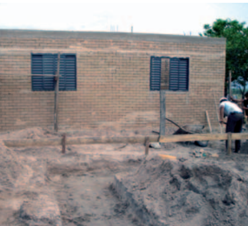
Atual situação da edificação de uma casa construída, no Município de Barra do Bugres/MT
